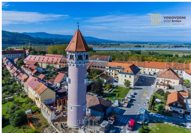
Vodovodni stolp Brežice.
